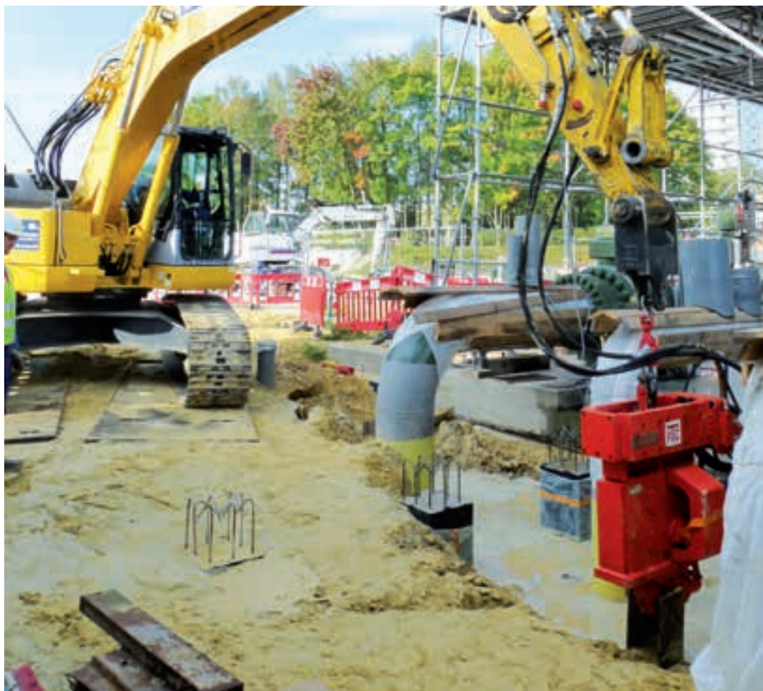
Le 2PHFV a été monté sur une pelle 23 t Komatsu.
